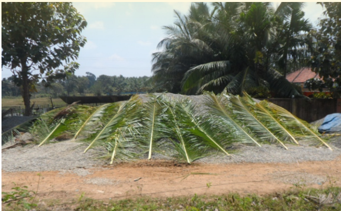
වැඩබිමක රැස්කර ඇති ඉදිකිරීම් ද්‍රව්‍ය මගින් නිකුත්වන දූවිලි පාලනය සඳහා පරිසරයේ ඇති අමුද්‍රව්‍ය යොදාගෙන ඇති අවස්ථාවක්.
